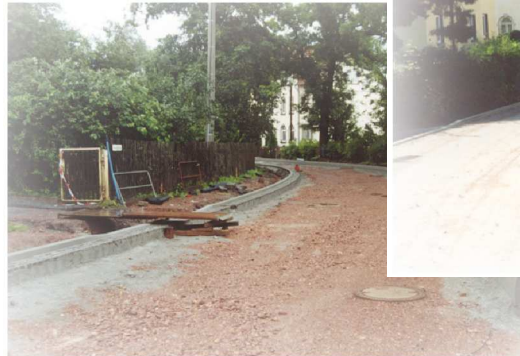
während der Baumaßnahme
