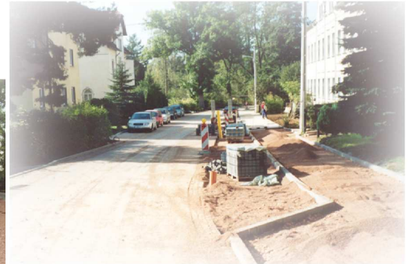
während der Baumaßnahme
