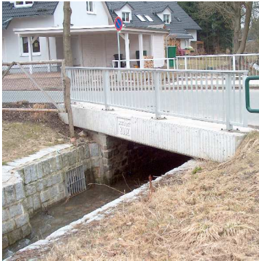
Brücke nach der Fertigstellung
